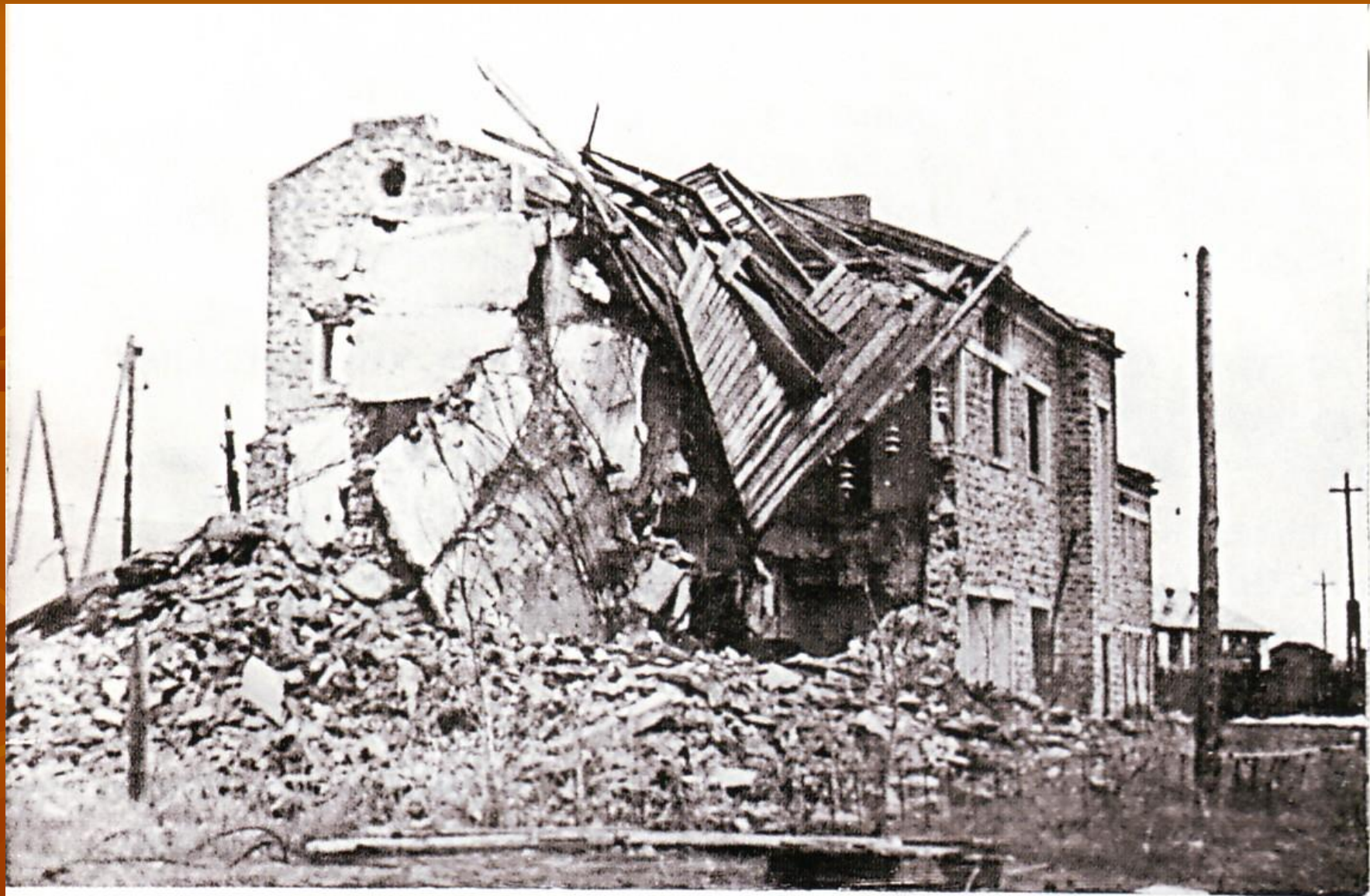
РАЗРУШЕННАЯ ШАХТА ИМ. КРАСИНА
